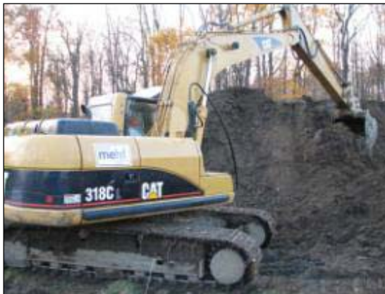
1. Зачерпывание полного ковша земли.
